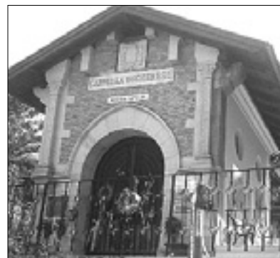
Madžarska kapelica pri Vižintinih
