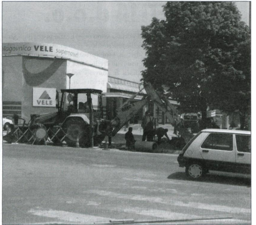
Dela za izgradnjo obeležja v Ivančni Gorici so v maju potekala zelo intenzivno.
