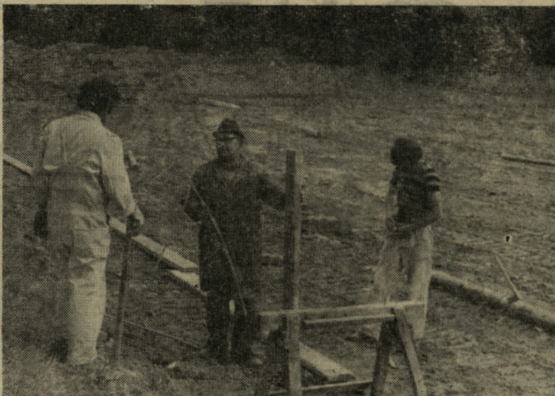
Delavci TOZD Gradbeništvo so zasadili prve lopate za novo betonarno, ki jo bodo — tako pravijo — končali v rekordnem času
