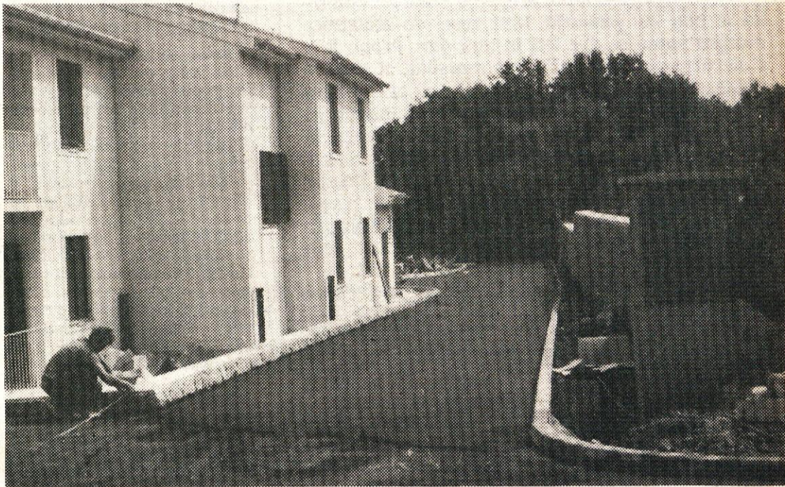
Na približno 4000 m 2 velikem prostoru je urejeno tudi za igrišča, površine za zelenje in počitek. Asfalt so že položili.
