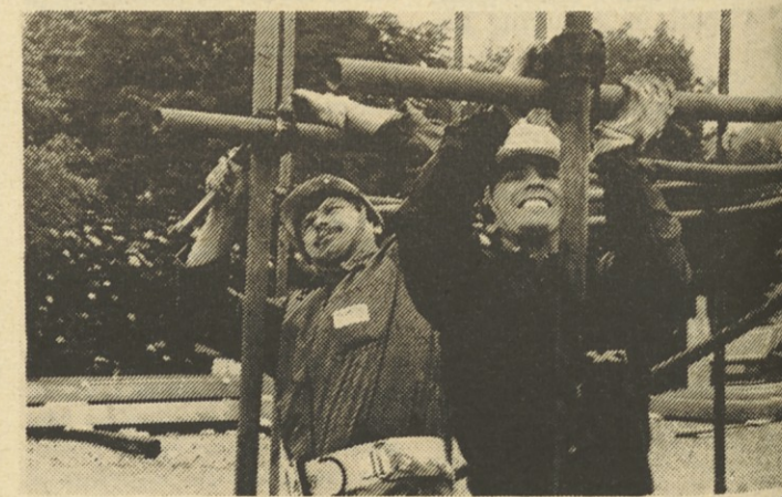
Postavljalci odrov pripravljajo železne cevi za »vogal« stavbe.
