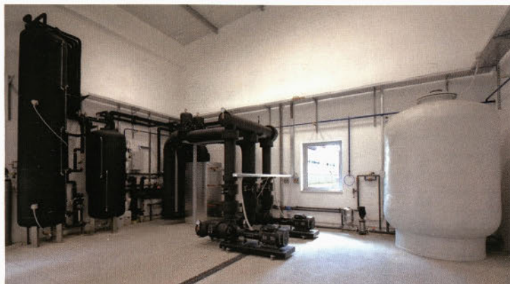
Del strojnice zaprtega hladilnega sistema za Ulital
