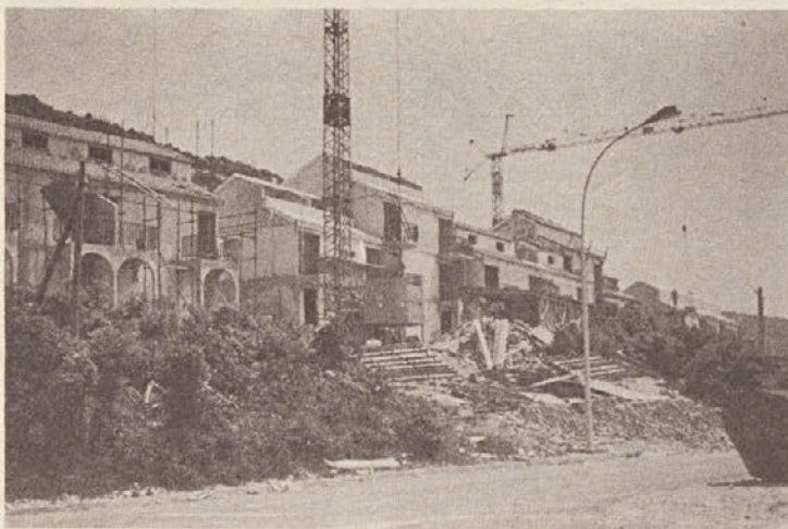
II. faza izgradnje stanovanjskega naselja Miholašćica na Cresu (foto: Borsan)
