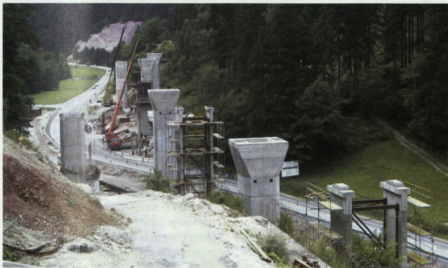
Slika 2 • Vmesne podpore viadukta
