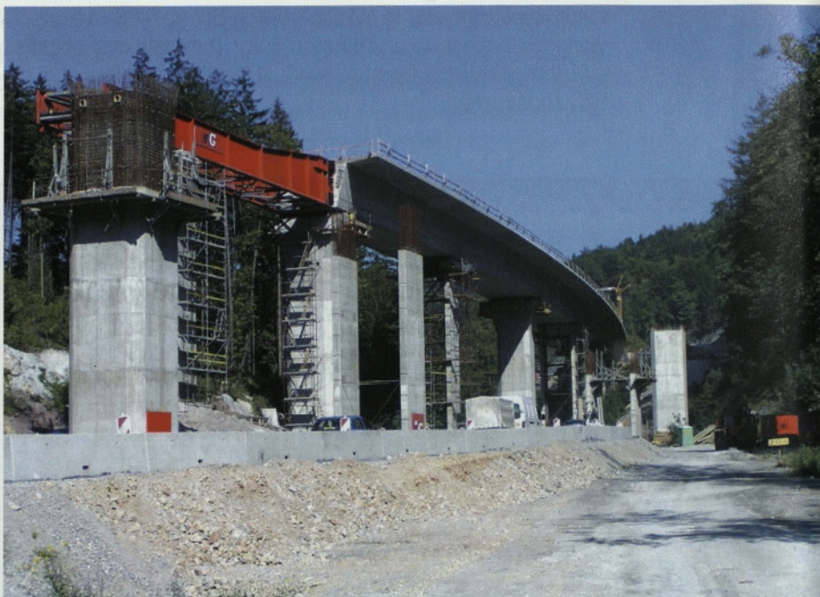
Slika 1 • Gradnja viadukta 6-6 Šentožbolt (oktober 2003)
