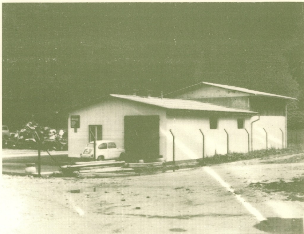
Naše skladišče v Dravogradu. Zadnji višji del je bil zgrajen letos
