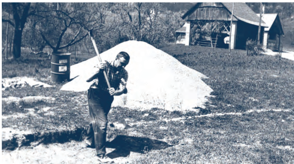
Ivan – začetek gradnje nove hiše; leta 1970.
