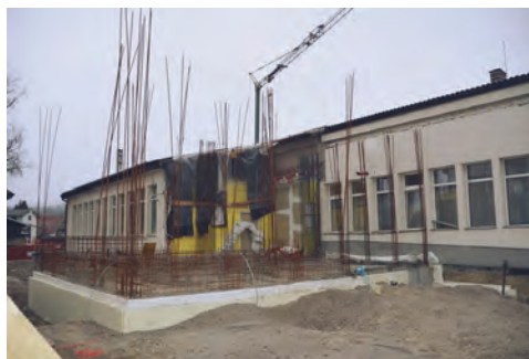
Gradnja prizidka pri zdravstvenem domu.
