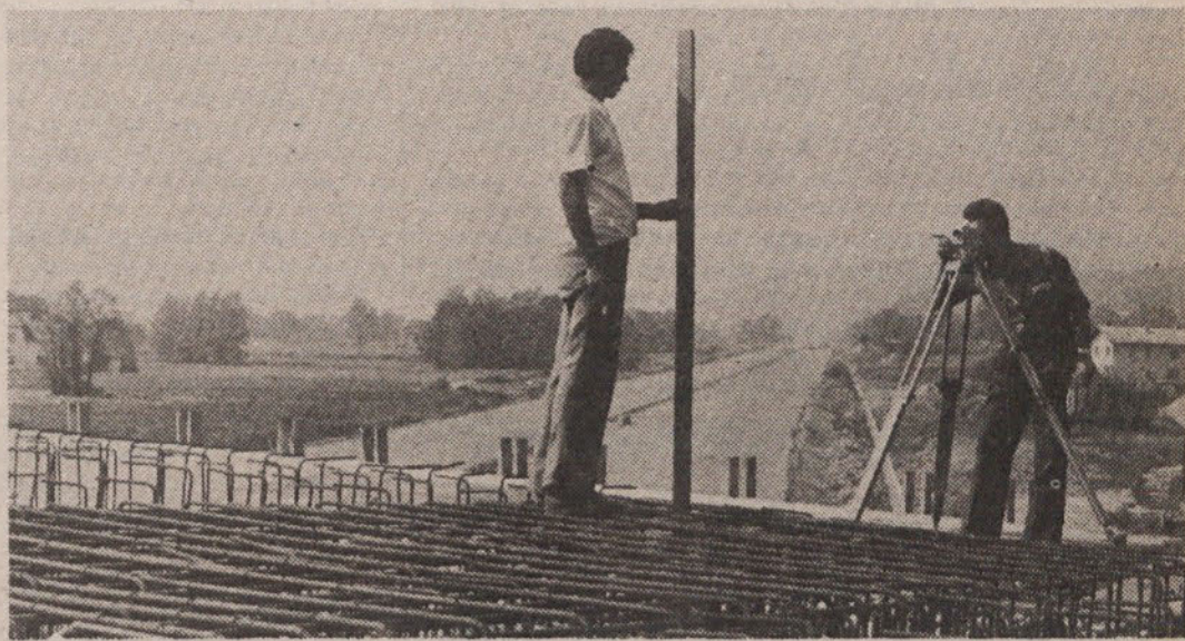
Strokovnjaki opravljajo tako rekoč še finalna dela na novi avto cesti Vrhnika—Dolgi most
