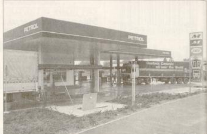
Nov izziv - gradnja bencinskih servisov. Bencinski servis na Ormoški cesti v Ptuj
