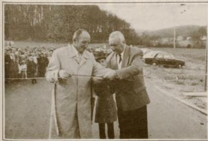
Završko obvoznico ob zeleni meji sta odprla Franc Majcenovič in Jožef Kopše
