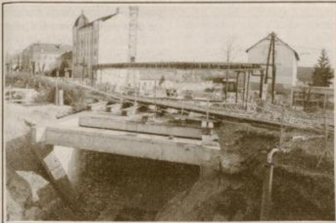
Podvoz je pod železnico
