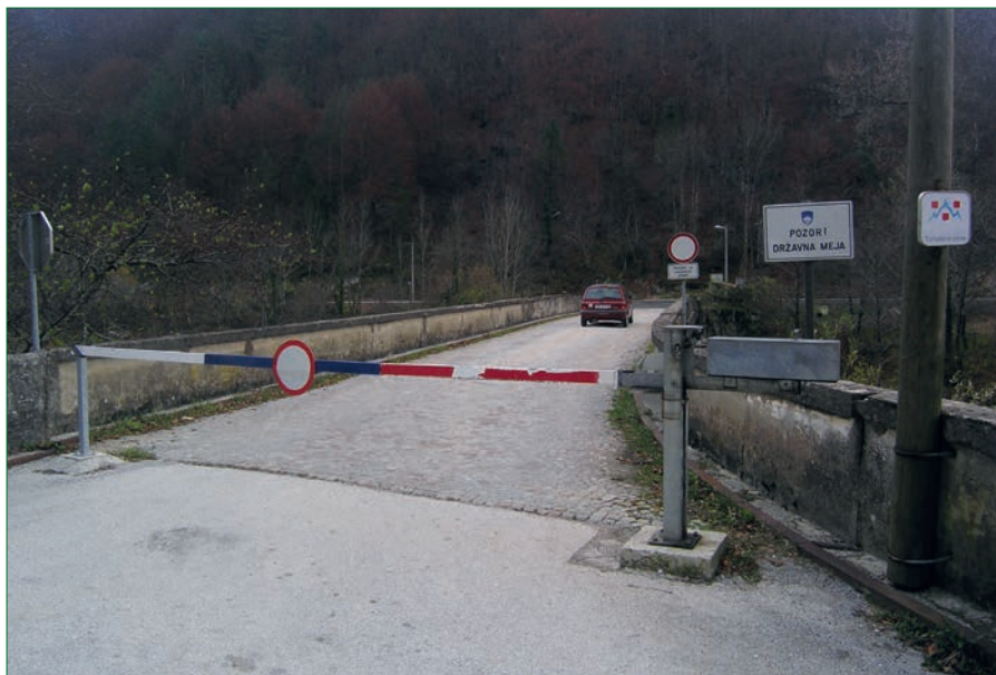
Z vzpostavitvijo državne meje je most prek Kolpe v Mirtovičih dobil status prehodne točke. Foto: Primož Pipan.
