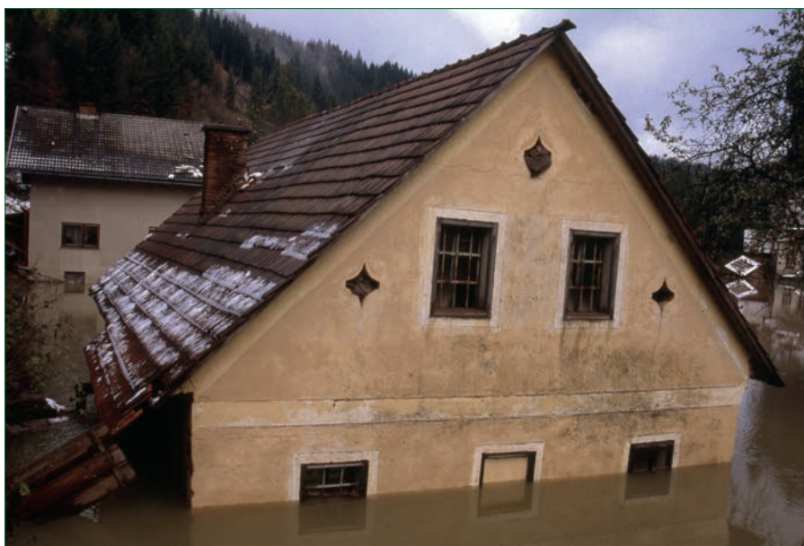
Poplavljene hiše v plazovnem jezeru. Foto: Drago Kladnik.
