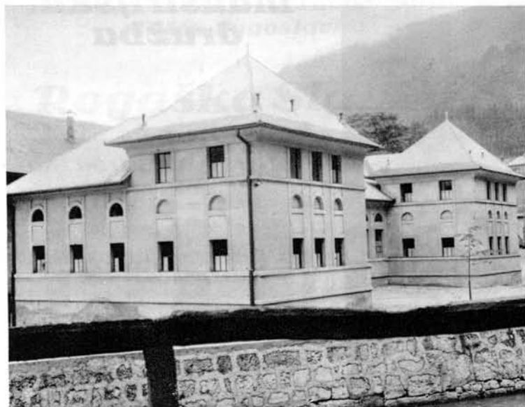
Kopaljšče Kotredež rudnika Zagorje
