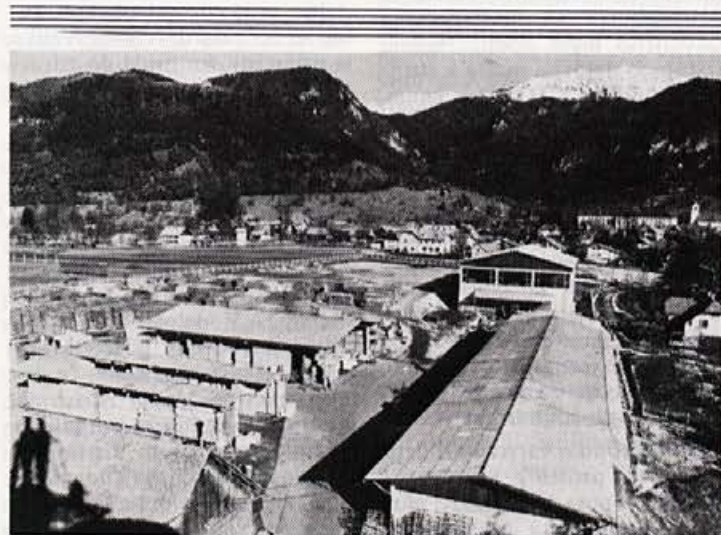
Del skladišča lesa, skladišče TO, Begunje (foto Resman)
