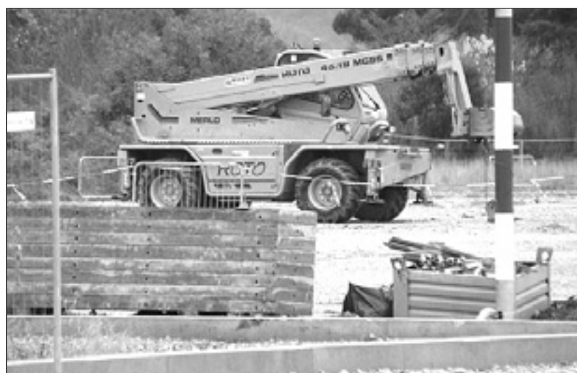
Celotna zemeljska infrastruktura je že narejena
