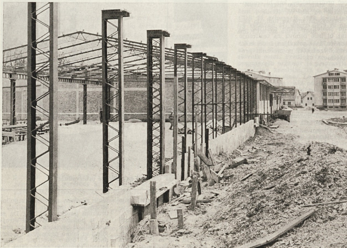
Gradnja skladišča TP Cerknica poteka po načrtu
