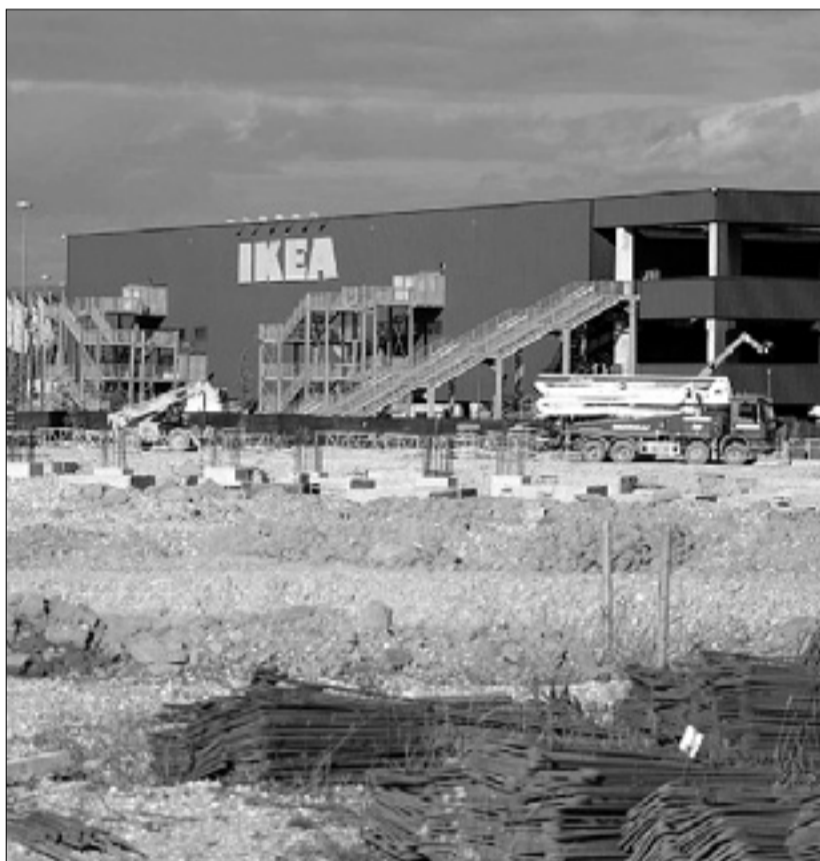
Gradbišče novega komercialnega parka BUMBACA
