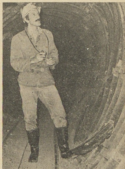
Na VI. obzoru jame Kotredež je progo v H-66-0., ki leži v talni glini precej stisnilo in zamaknilo.
