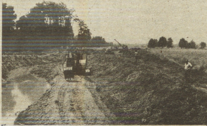
Dela pri regulaciji potoka Ledava, ki jih izvaja Vodno gospodarstvo Drava—Mura, so bila že več kot potrebna. Posnetek je narejen ob cesti Gančani—Bogojina.
