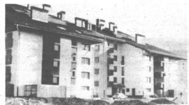
Na področju komunalne infrastrukture je pomembna izgradnja 32-stanovanjskega bloka v Nazarjah
