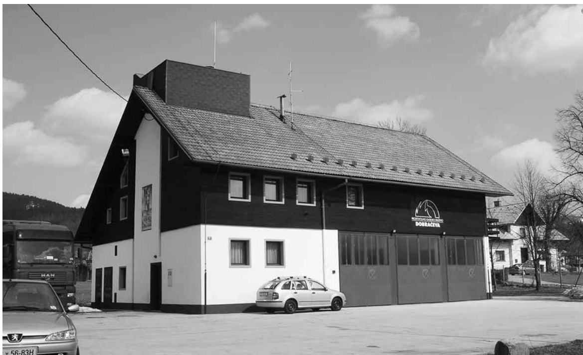
Gasilski dom na Dobračevi, zgrajen po načrtu Danila Oblaka.
