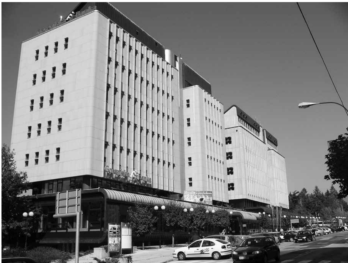
Gorenjska banka in Uprava policije Kranj, stavbi sta bili zgrajeni po načrtih Danila Oblaka.
