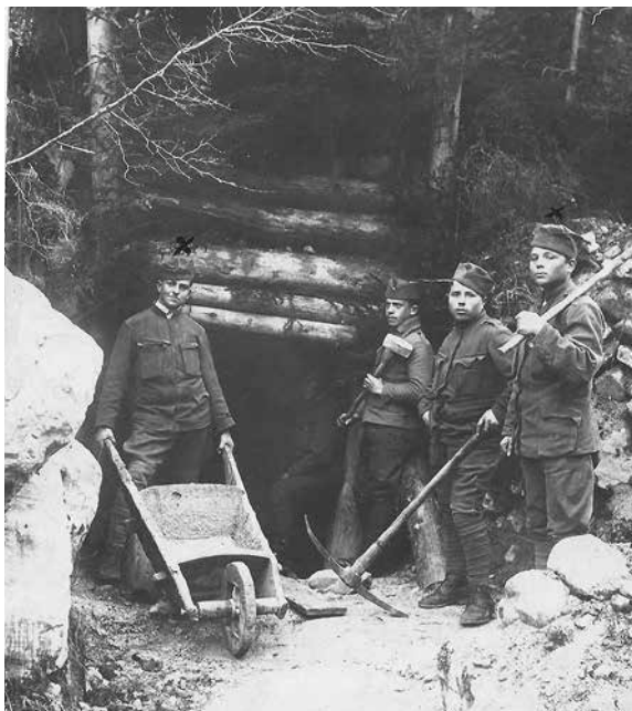
Gradnja zaklonišča pri Podrožci pozimi 1919, pripadniki 3. artilerijske baterije, Žirovca Ivan Kopač (levi) in Lovrenc Šubic (desni), s kladivom verjetno Andrej Primožič (roj. 11. 11. 1898, Kopačnica). / Fotografijo hrani Milan Kopač, Bedrih, Žiri.
