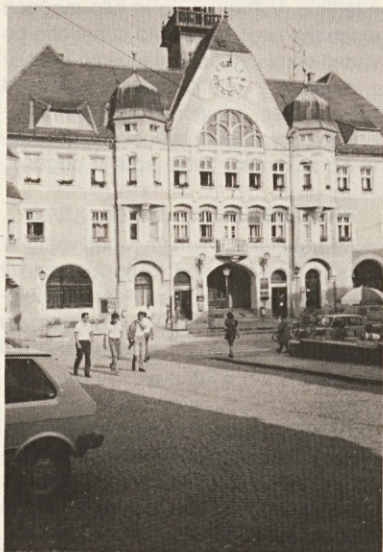
Rotovž z baročnim pročeljem v Ptuj.
