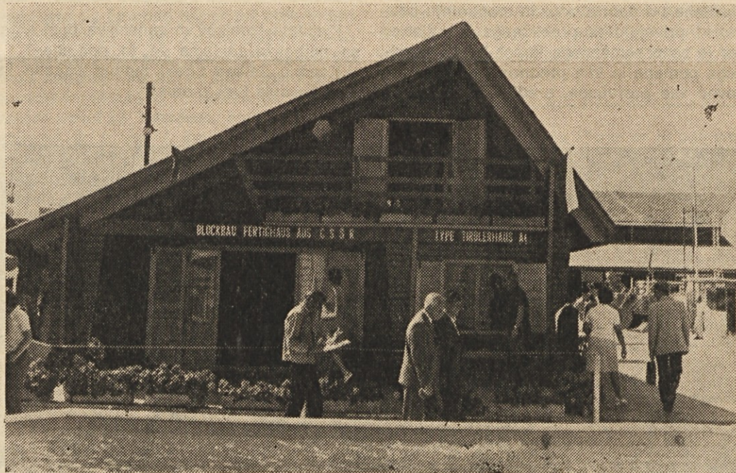
Bistveno prenovljena češkoslovaška gotova hiša, že več kot senzacija in prodajni šlager Celovškega velesejma.
