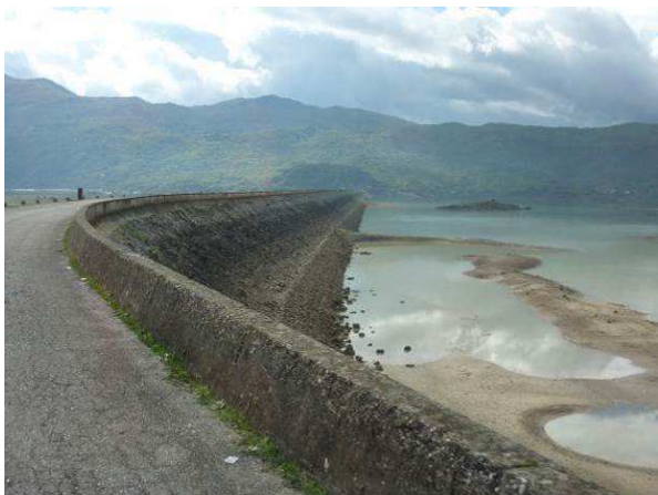
Slika 10: Severni konec pregrade Slano.
