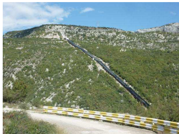
Slika 16: Tlačni cevovodi HE Peručica; zgornji, svetlejši del je na novo protikorozijsko zaščiten
