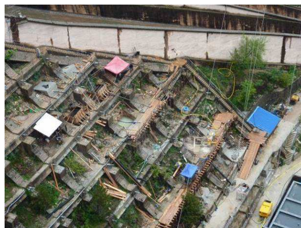
Slika 6: Sidrno polje na levem boku pregrade je zaradi postopnega popuščanja sider v fazi sanacije
