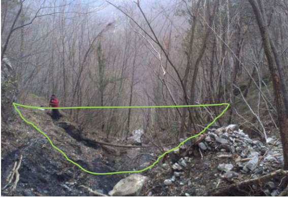
Slika 8: Izbran pregradni profil v hudourniku
