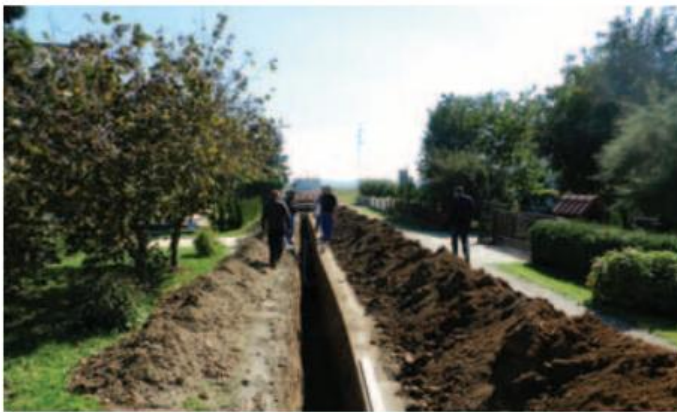
KANALIZACIJA: Izvedli smo 15.291 metrov kanalizacijskega sistema po občini s skupaj 453 priključki
