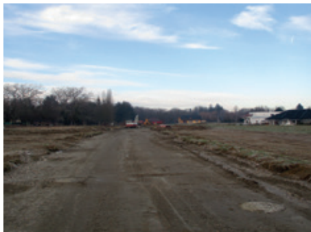
Izgradnja kanalizacije pri vinski kleti
