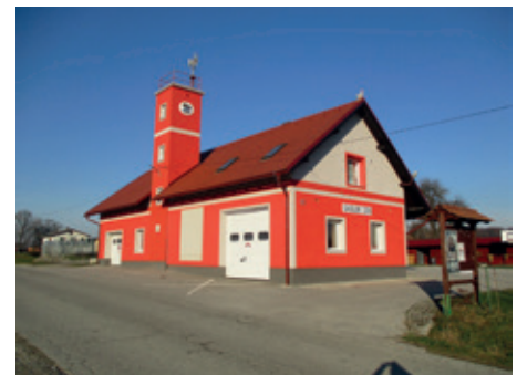
Obnova fasade, Gasilski dom Ključarovci
