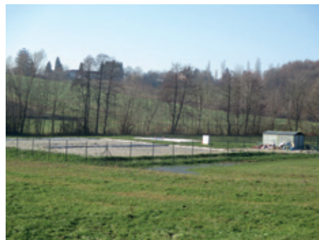
Izgradnja čistilne naprave Lačaves
