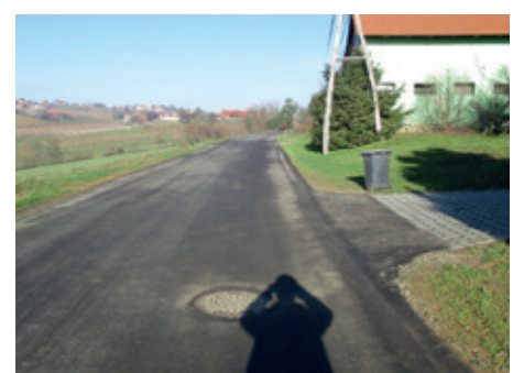
Izgradnja kanalizacije, Jastrebcji
