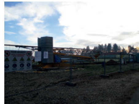
Začetek gradnje tribun pri nogometnem stadionu, Ormož
