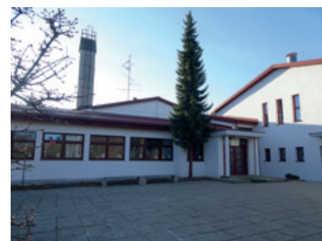
Oš Ivanjkovci, energetska sanacija
