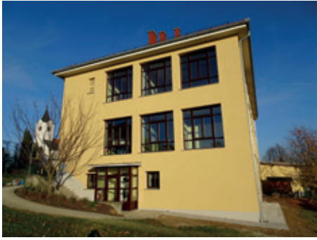
OŠ Kog, energetska sanacija
