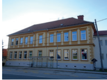
OŠ Miklavž, energetska sanacija
