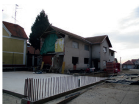
Prenova stare komunale, začetek gradnje
