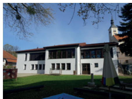
Vrtec Miklavž, energetska sanacija
