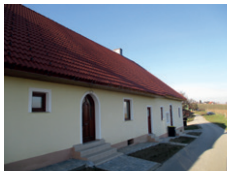
Obnova objekta, Cerovec Stanka Vraza
