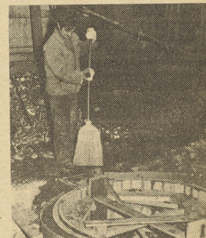
Temelj za enega novih livarskih strojev pripravljajo.
