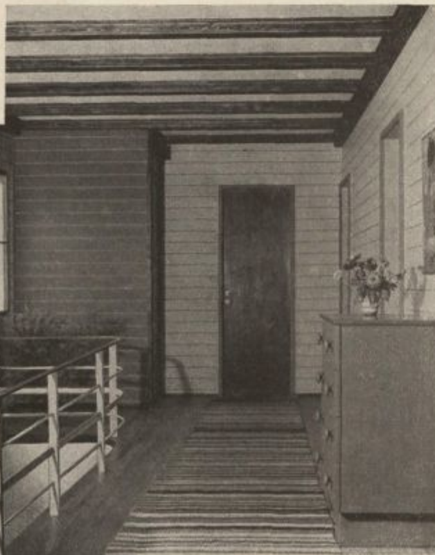
Stopnišče dvodružinske hiše, zgrajene v močnih kontrastih. Strop je belo popleskan, tramovi so temni, impregnirani s spajalko. Posamezne stenske deske so vodovarno poudarjene z barvastimi črtami.
