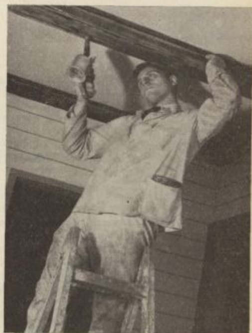
Kako uporabljamo spajalko na stropnih tramih. Mehki les izgori, smočnati zogljeni in postane temnorjav. S tem tudi les impregniramo. Se lepši so tramji, če jih potem odrgnemo z žičnato ščetjo.
