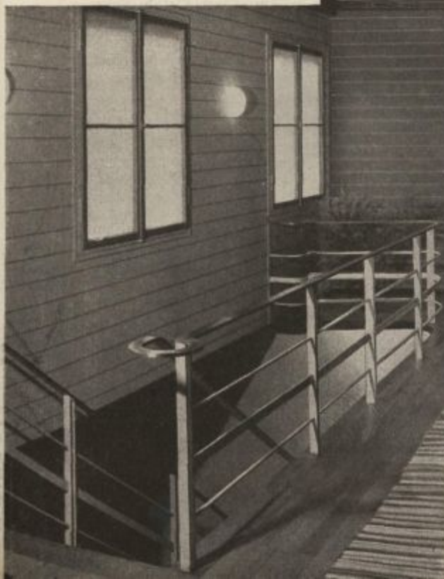
Stopnišče dvodružinske hiše, zgrajene v močnih kontrastih. Strop je belo popleskan, tramovi so temni, impregnirani s spajalko. Posamezne stenske deske so vodovarno poudarjene z barvastimi črtami.
