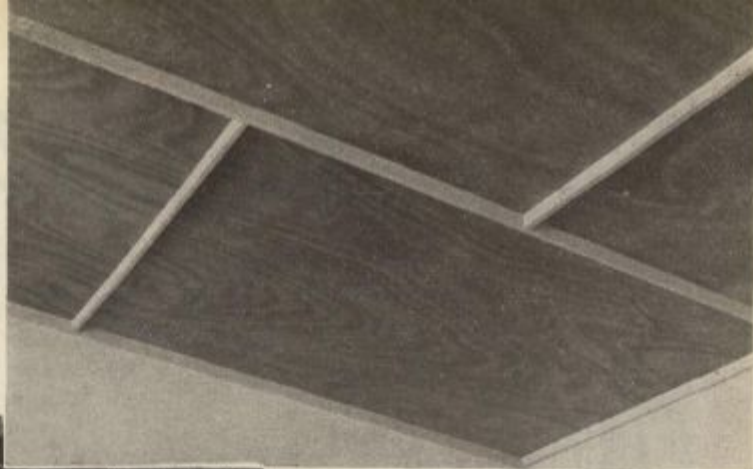
Strop z velikimi ploškami, ki jih plastično označujejo in v barvi poudarjajo letve. Stropne ploške so izlužene v tonu pohištva. Stene so gladke in svetlo popleskane. V tem primeru njih porazdelba ni poudarjena.
