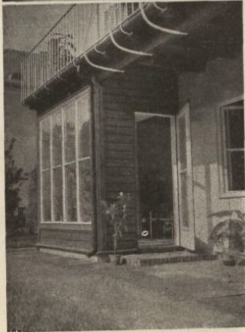
Veranda v pritličju lesene hiše z izhodom na vrt. Leseni deli so popleskani s harbolinejem, drugo pa je belo. Tla v pritličju, kjer navadno sedimo, so iz rdečih peščenih plošč, med katere je vdelana prepeka. Izhod v gornje nadstropje ima letvasto mrežo kot tla in je zavarovan z železno ograjo. Na sliki zgoraj vidimo notranjščino pomolov. Svetlo popleskane stene in strop se lepo podajo k pestrim barvam cecilic in rastlin.
