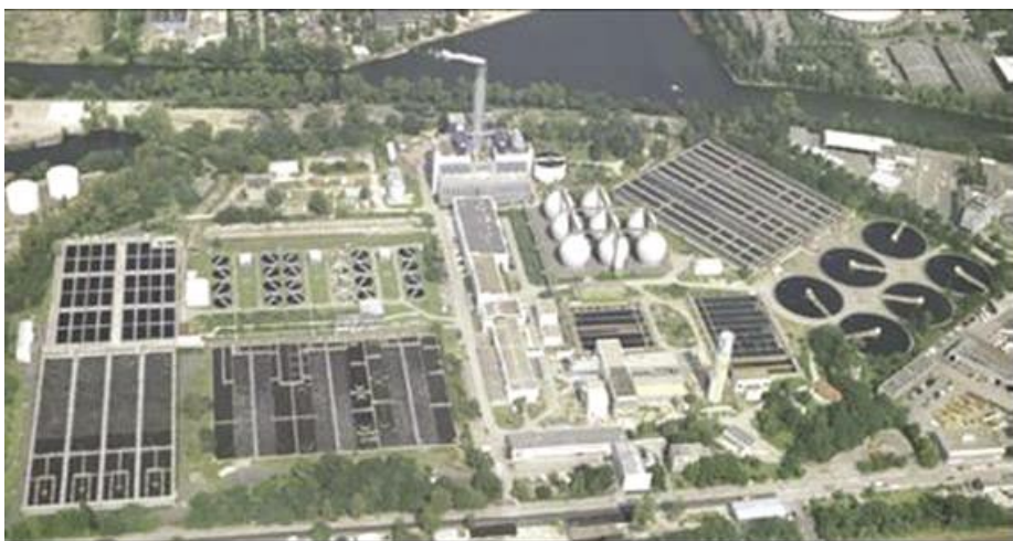
Slika 1 • Čistilna naprava RUHLEBEN v Belinu čisti 1,6 mio. PE, 2,86 m 3 /s sušnega in 6,9 m 3 /s padavinskega dotoka. Že leta 1985 so opustili 8 anaerobnih reaktorjev za proizvodnjo bioplina (gnilišč) s po 6.500 m 3 , skupaj 52.000 m 3 prostornine. Sedaj so uporabljeni za izravnalni rezervoar blata pred njegovim sežigom.
