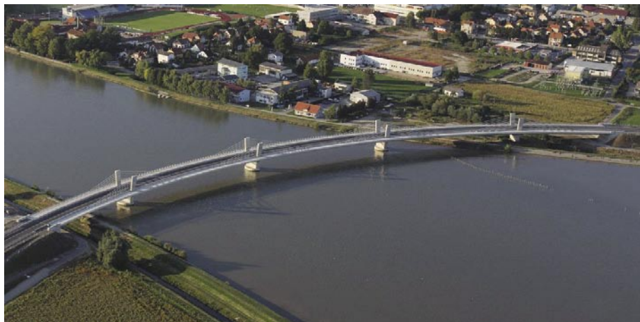
Slika 2 • Pogled na Puhov most iz zraka
