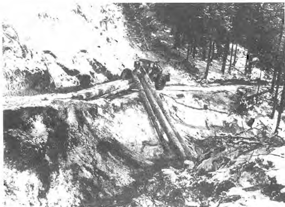
Slika 6. Če manjkajo odrivači, se obrusi spodnji rob poti ali nasipa
