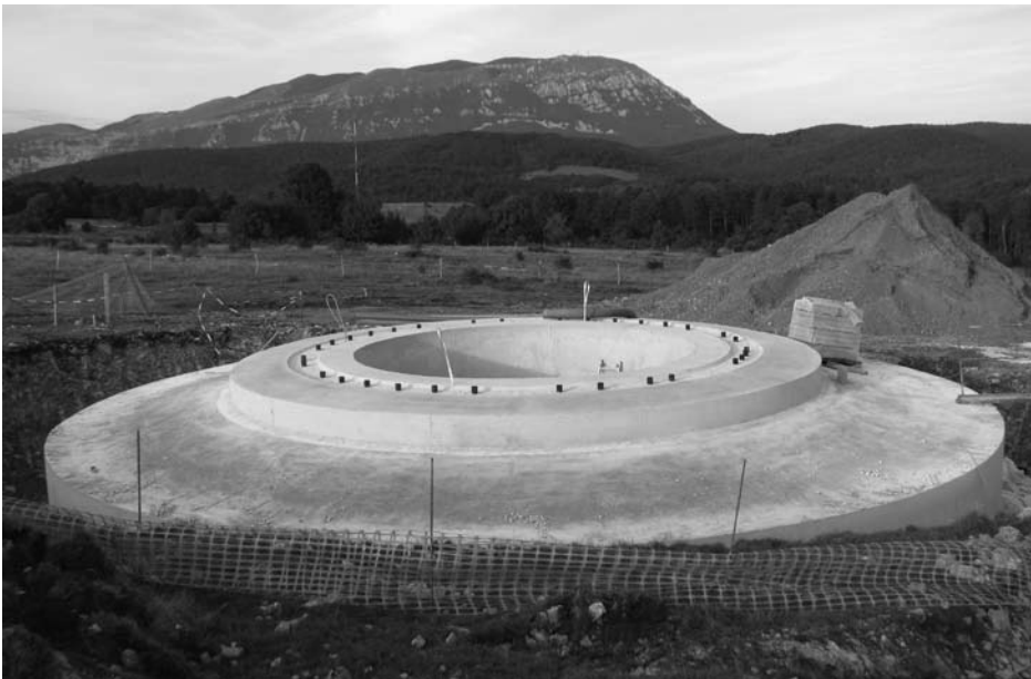
Slika 3. Betonski temelj vetrne elektrarne Dolenja vas
