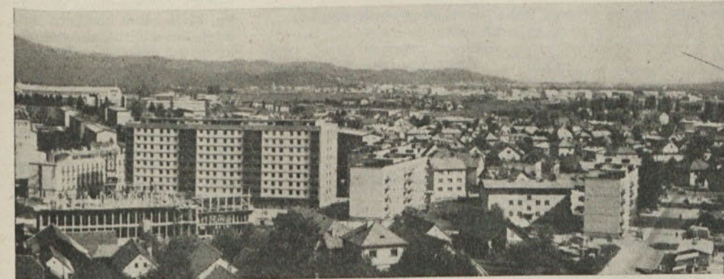
Med manjšimi zasebnimi hišami so začeli hiro rasti novi stanovanjski bloki. Taki veliki bodo v nekaj letih spremenili naše predmestje v novo mestno središče. Na sliki: Pogled s smučarske skakalnice. V ospredju je v gradnji nova osnovna šola Na jami (Foto: Mario Vilhar)
