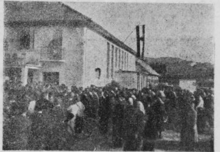
Novozgrajen zadrudni dom s prosvetno dvorano v Muretincih
