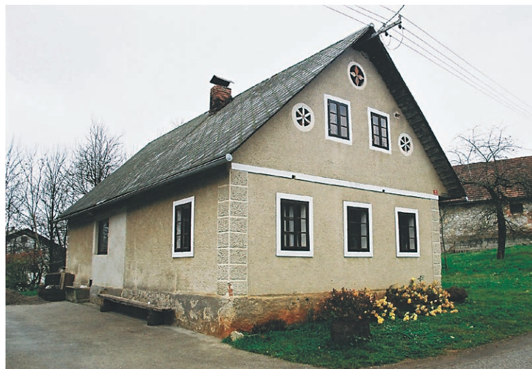
Ena od značilnih hiš v Velikem Nerajcu; čeprav jih je veliko praznih, so jih vaščani obnovili, zato so leta 2000 v evropskem projektu CRPOV dobili posebno priznanje
