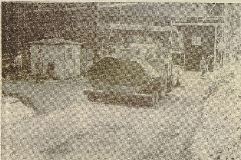
Asfaltiranje novih prometnic v Štorah I. ob ukinitvi ozkotirne železnice
