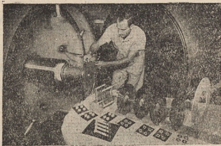
Jenski motor za vesoljsko zračno ladjo pripravljajo v ameriškem raziskovalnem centru v Clevelandu, Ohio. Na sliki vidimo znanstvenika, ki sestavlja posamezne dele takega motorja, ki naj bi oskrboval zemeljski satelit v bodočnosti
