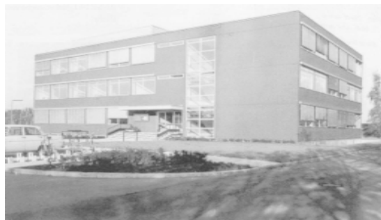
Inštitut po obnovi leta 1991
