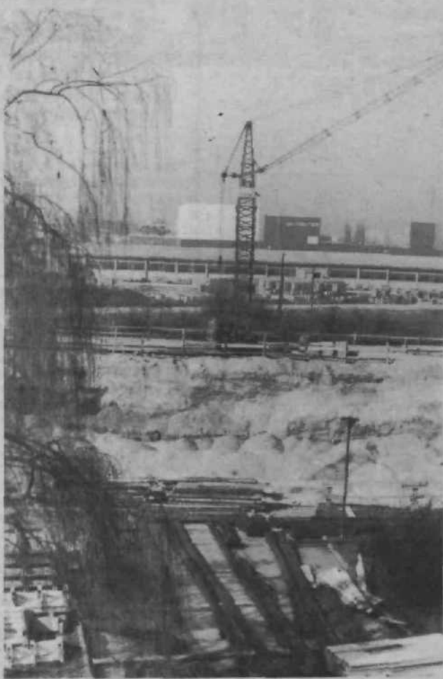
Pri Ljubljanskih mlekarnah na Tolstojevi cesti so že izkopali temelje za novo tovarno za predelavo mleka in za veliko skladišče sirov. Na gradbišču je iz dneva v dan bolj živahno.
