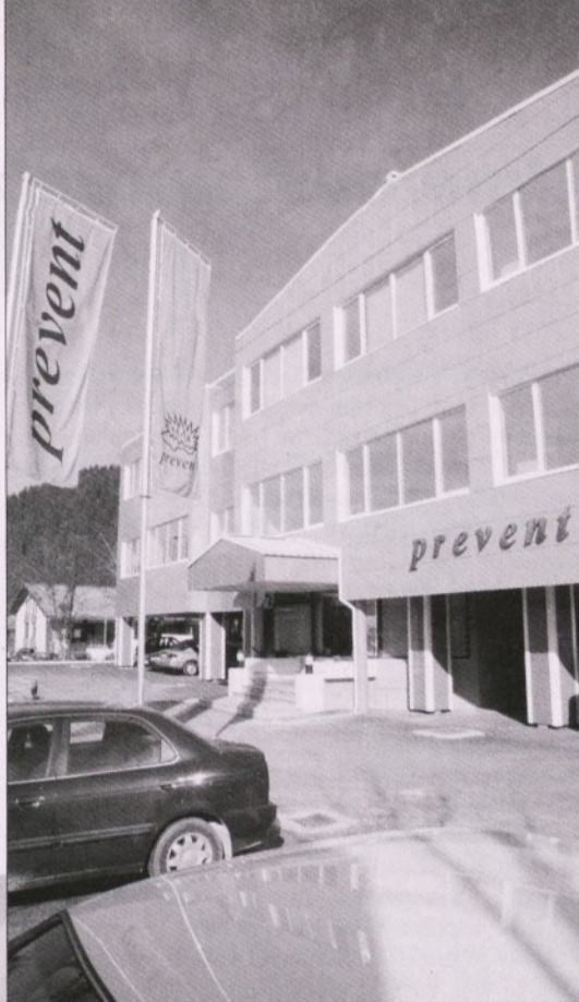
Upravna stavba Preventa v Slovenj Gradcu
