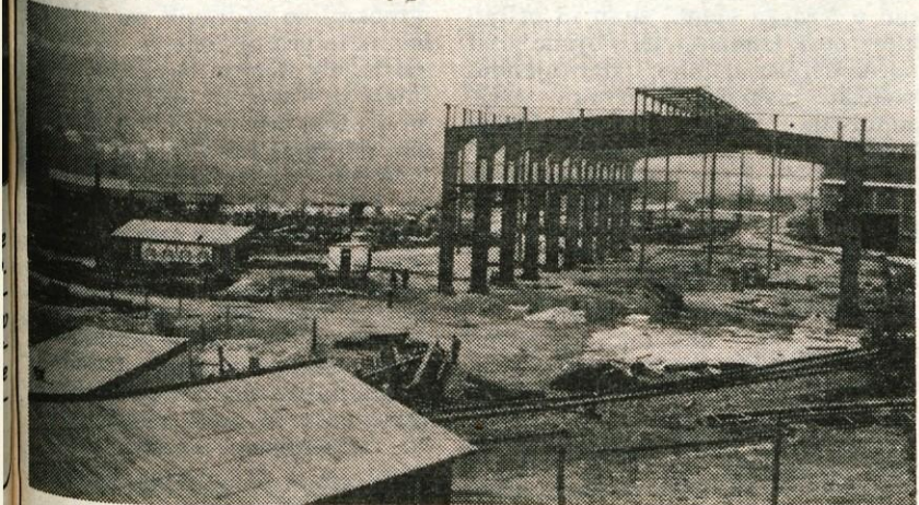
Na Gorenjskem ima Gradis trenutno dve veliki gradbišči, novo jeklaro na Jesenicah in vodno elektrarno v Mavčičah. Foto: D. Dolenc
