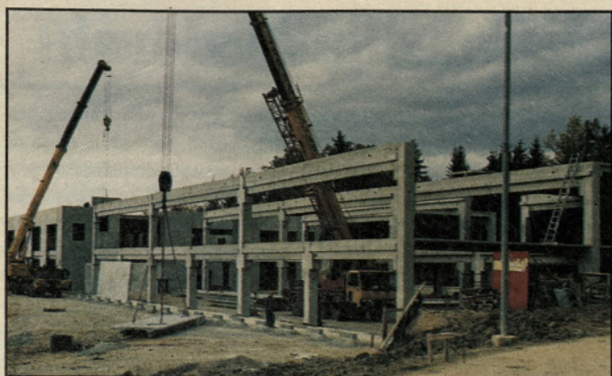
Gradnja poslovnega objekta v Arnovskem gozdu
