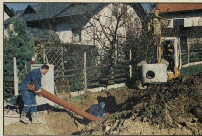
Pri polaganju kanalizacijskih cevi na Terasah
