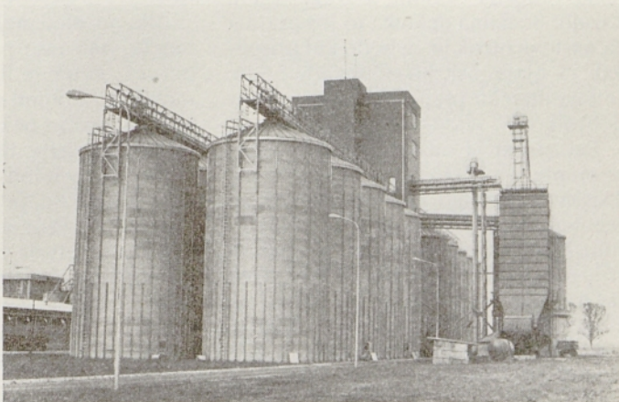
Silos ITAS za skladiščenje žitaric, kapaciteta objekta 20.000 ton izdelujemo silosne celice od 50 m 3 -2500 m 3
