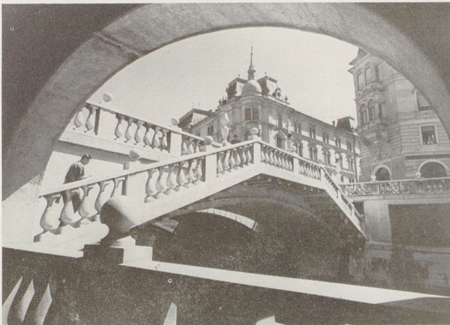
Detajl z ljubljanskega Tromostovja, kot ga je zasnoval arhitekt Jože Plečnik (foto: Marjan Zaplatil)
