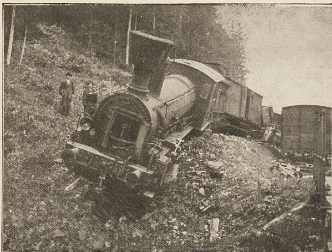
Železniška nesreča na Vrdu nad Vrhniko 9. t. m.: Tovorni vlak, ki je skočil s tira ter zavozil na hrib. Fot. A. Lebez v Borovnici.
