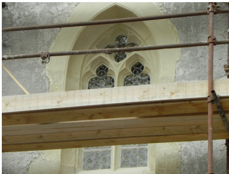
Slika 2: Materialni vidik: celostna prenova Knežjega dvorca, Celje. Faza prenove 2012 je vključevala tudi visoko usposobljene obrtnike, ki so, med drugim, na novo sklesali gotska okna (foto: B.Vodopivec).
