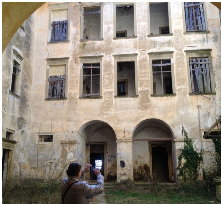
Slika 8: Vizulani pregled stanja ohranjenosti objekta. Grad Podčetrtek, 2014 (foto: R. Žarnić).
