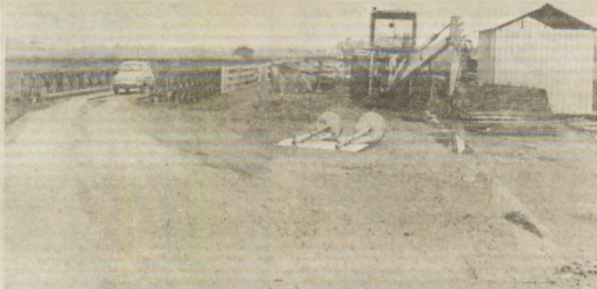
Inženirci Vojaške pošte 4680 Celje so v osmih urah postavili čez potok Borošnjak pri Mostju začasen montažni most, po katerem lahko peljejo vozila do 20 ton. Foto: Š. S.
