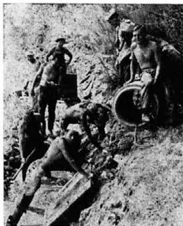
Gradnja zbirnega kanala
