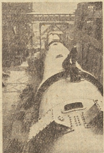
V trboveljski cementarni te dni montirajo novo klinker peč. Računajo, da bo začela obratovati še pred koncem leta. V njej bodo lahko izdelali približno 300 ton cementa dnevno, tako da se bo letna proizvodnja od sedanjih 80.000 ton povišala na 170.000 ton cementa
