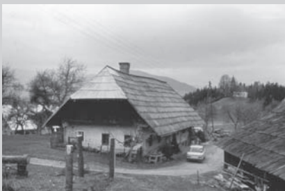
14. Šentjanž nad Dravčami. Skoraj v celoti lesena hiša, nekdanja dimnica, ima streho prekrito s skodlami (alpsko območje).
