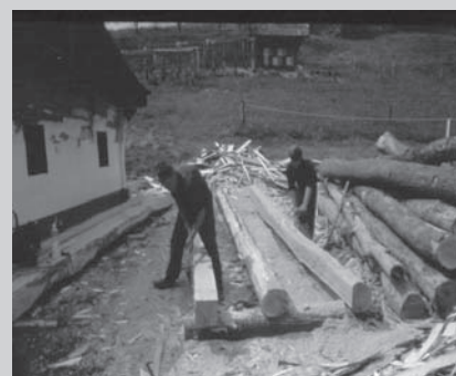
7. Muzej na prostem Rogatec. Tesarji pripravljajo kostanjev les za strešno konstrukcijo
