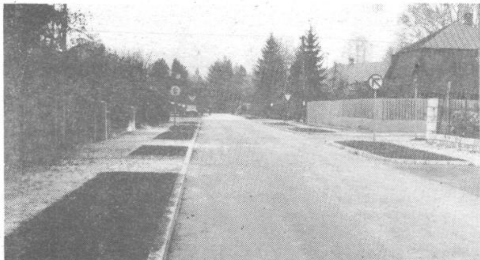
V zadnjih letih so asfaltirali in uredili Soško, Valjavčevo, Kopaljsko, Zeljarsko, Rezijsko in Mencingerjevo ceste ob Gradaščici. Na sliki pa je del Zbašnikove ulice, ki je zadnja dobila asfalt. Za 80 m ceste bo potrebno odšteti okrog 2 milijona dinarjev. Stanovanci so prispevali po 10 tisoč dinarjev.
